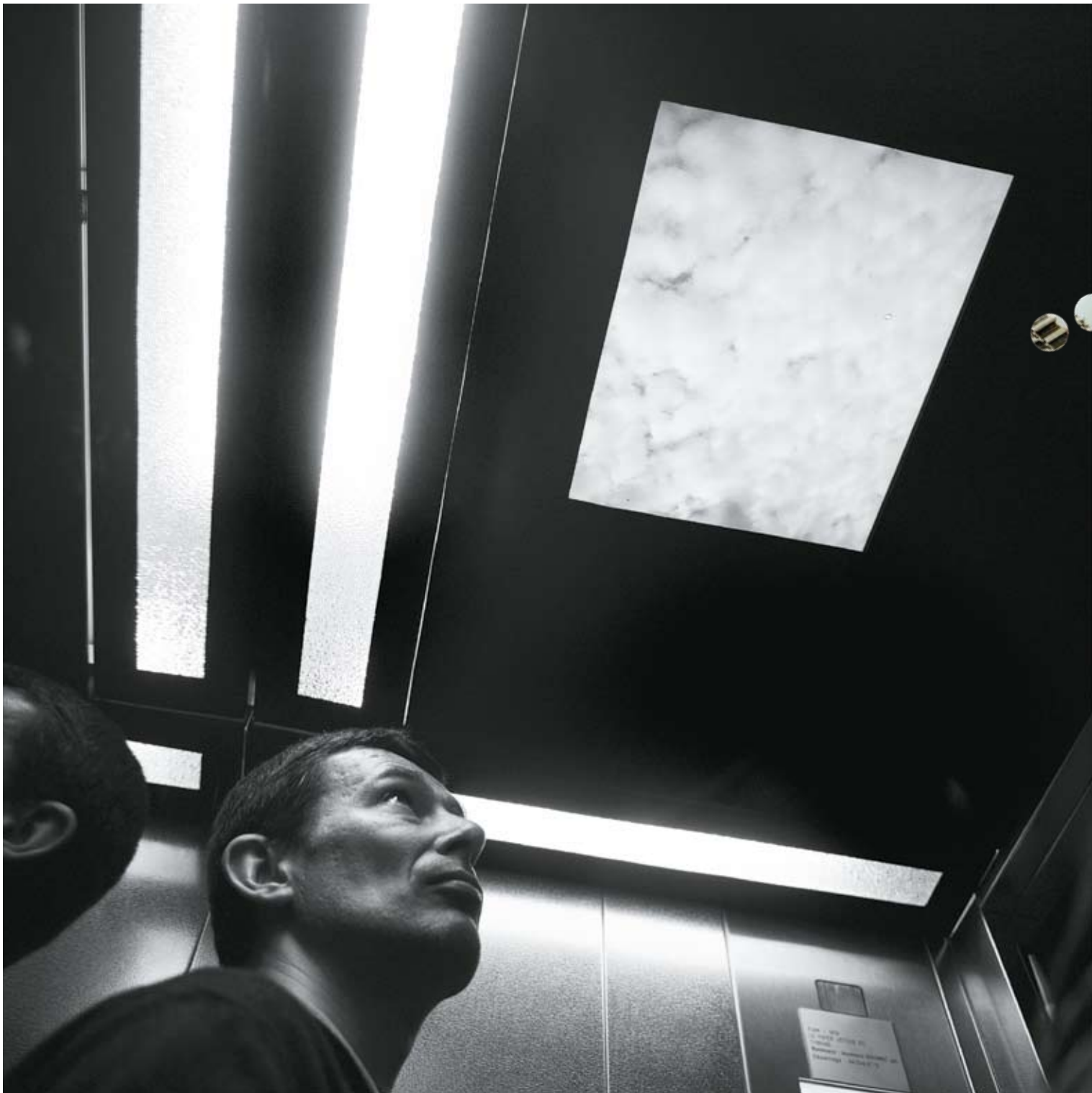
Le Foyer Jettois - Essegem, installation des plafonniers De Jetse Haard - Essegem, plaatsen van de plafondscheren
